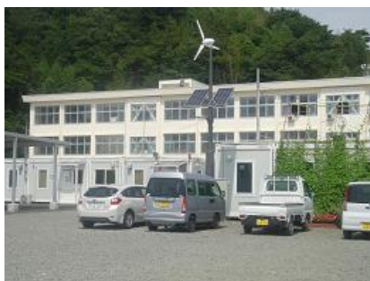
野蒜小学校には仮設市民センターが設置された
